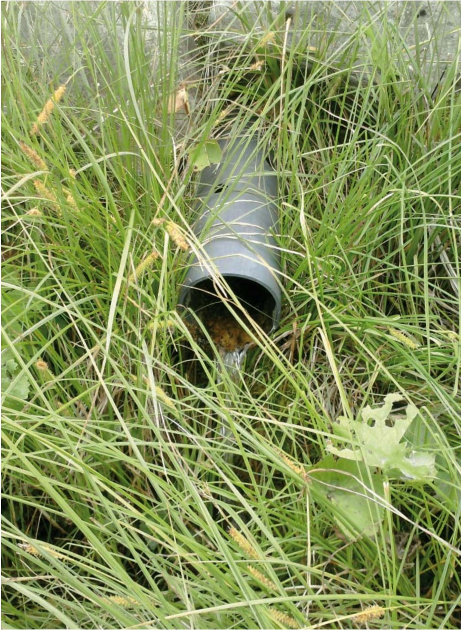
Einleitung von geklärtem Abwasser in ein Fließgewässer
